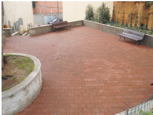
La plaza Cerdans, en el barrio de Can Ballell, después de la reforma, aunque aún falta mobiliario urbano y jardinería
