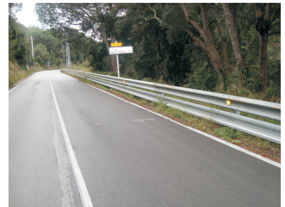
Sustitución de las barreras laterales en la carretera de Santa Cristina con protección para los motoristas
